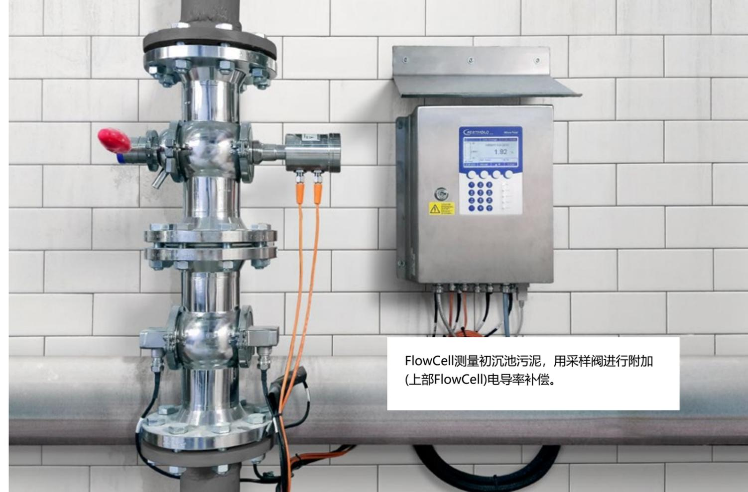
FlowCell测量初沉池污泥，用采样阀进行附加(上部FlowCell)电导率补偿。
